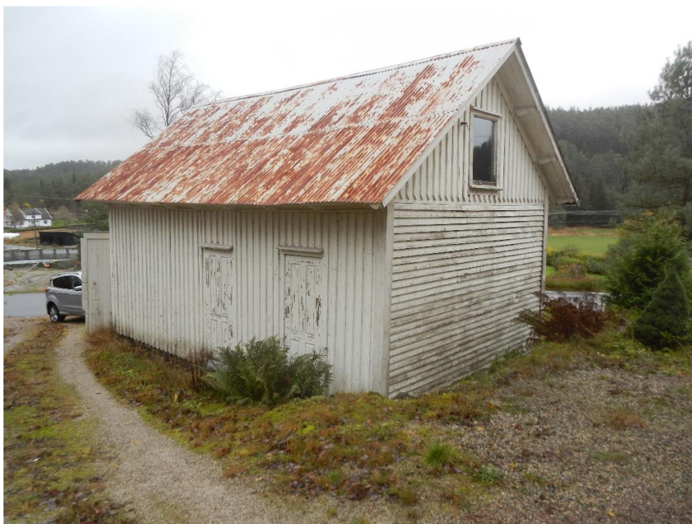
Lokalet sett frå baksida. Gavlveggen er skifta ut pga. råteskade. Foto: OF.
