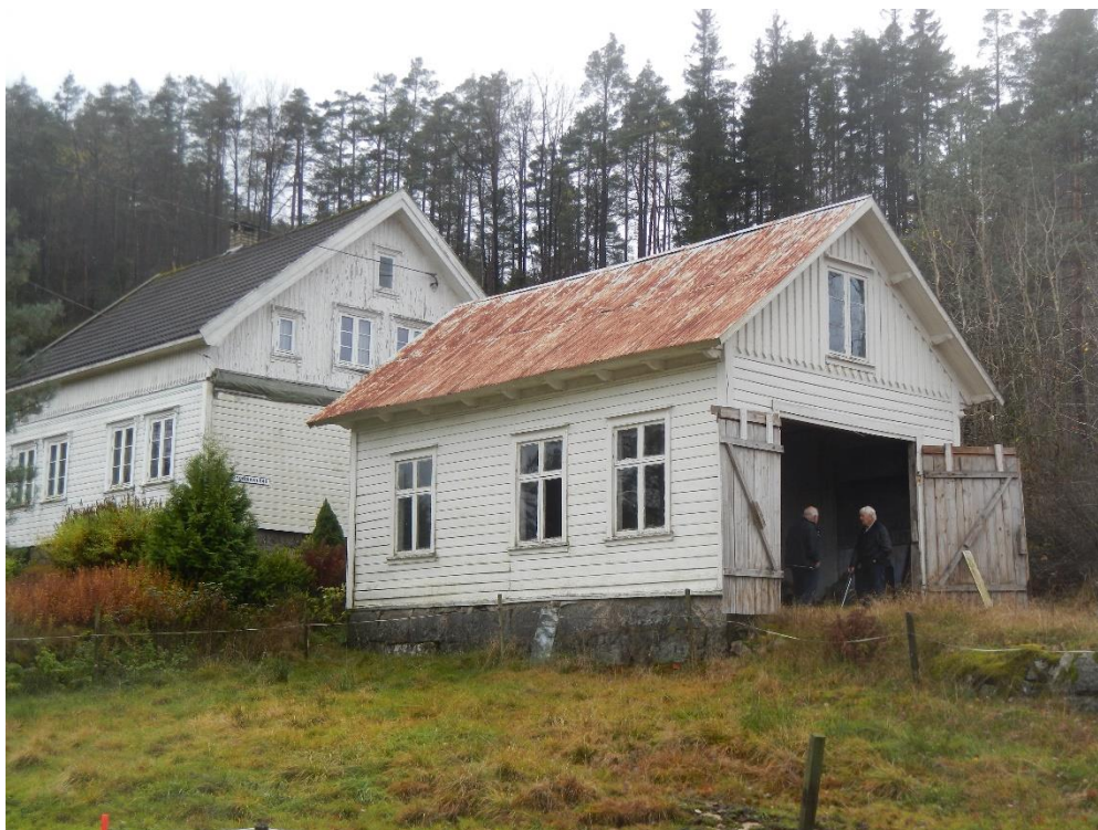
Kommunelokalet sett frå fylkesveg 461. I dag er huset brukt til garasje.
