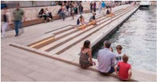
sittetrinn og båtslipp på eksisterende kaikant
