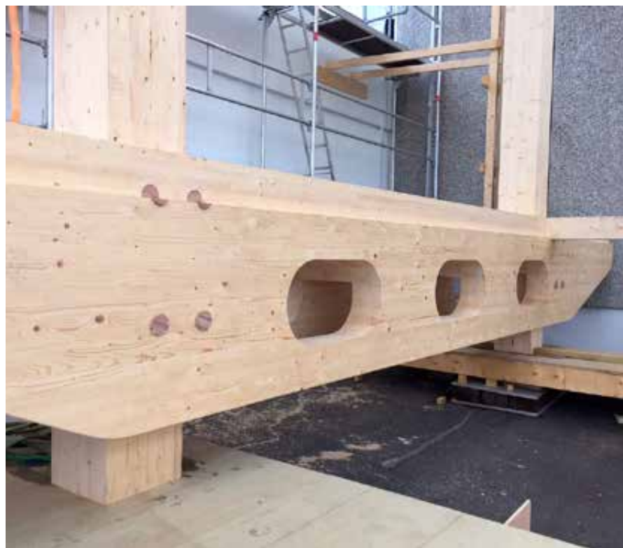
FINANSPARKEN - STAVANGER - KONSTRUKTIVE TREFORBINDELSER
