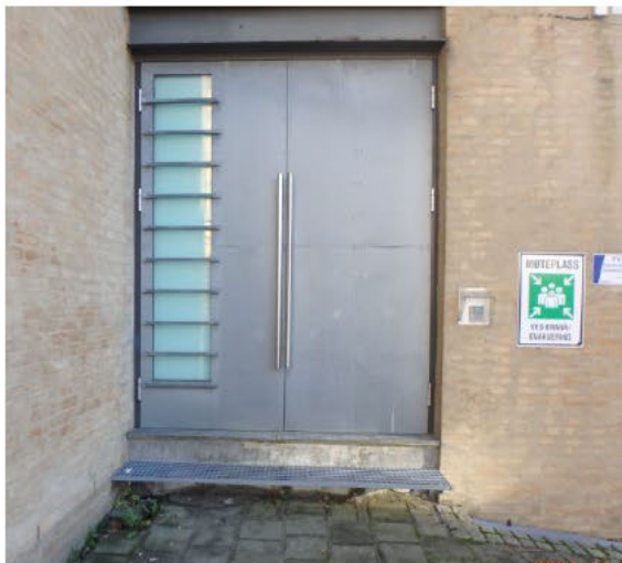
Bilde nr. 9 Viser ståldør år 2003, nødutgang (designdør)
