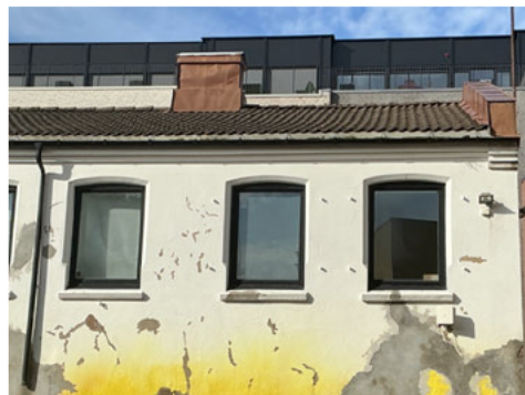
Betongstein på takflater mot bakgård
