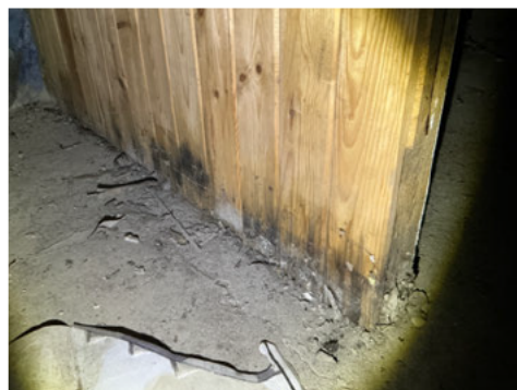
Fuktskader treverk
