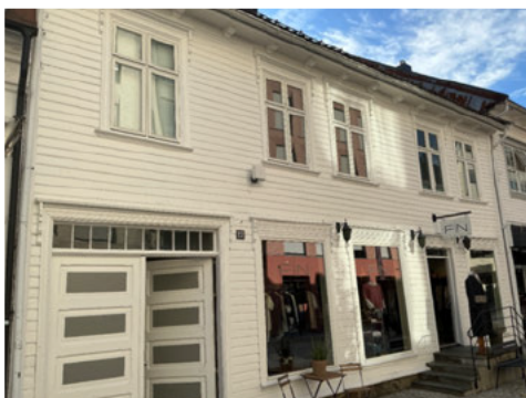
Fasade mot gate
