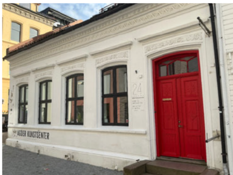
Fasade mot gate
