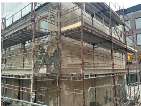
Pågående rehabilitering på endevegg
