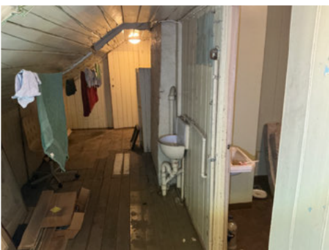
Loftetasje fremstår som et grovloft med mulighet lagring ol. Ikke boligstandard
