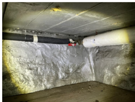
Vanninntak i kjeller
