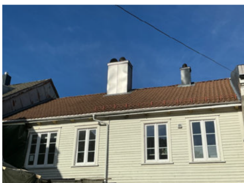
Betongstein på takflater bakside
