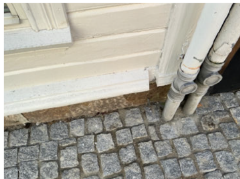
Taknedløp er ledet til overvannsrør.
