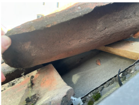
Stikkontroll av undertak fra takvindu
