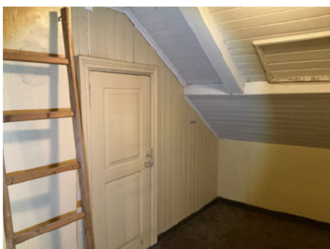
Loftetasje fremstår som et grovloft med mulighet lagring ol. Ikke boligstandard
