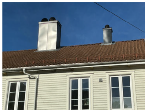
Pipe og lufting er helbeslått
