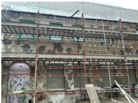
Pågående rehabilitering på bakside
