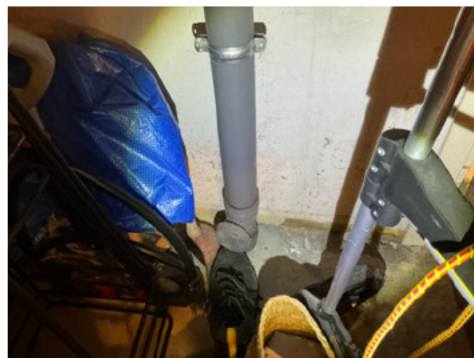
Stakeluke i kjeller
