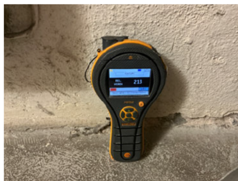
Svake/moderate utslag registrert ved bruk av fuktindikator
